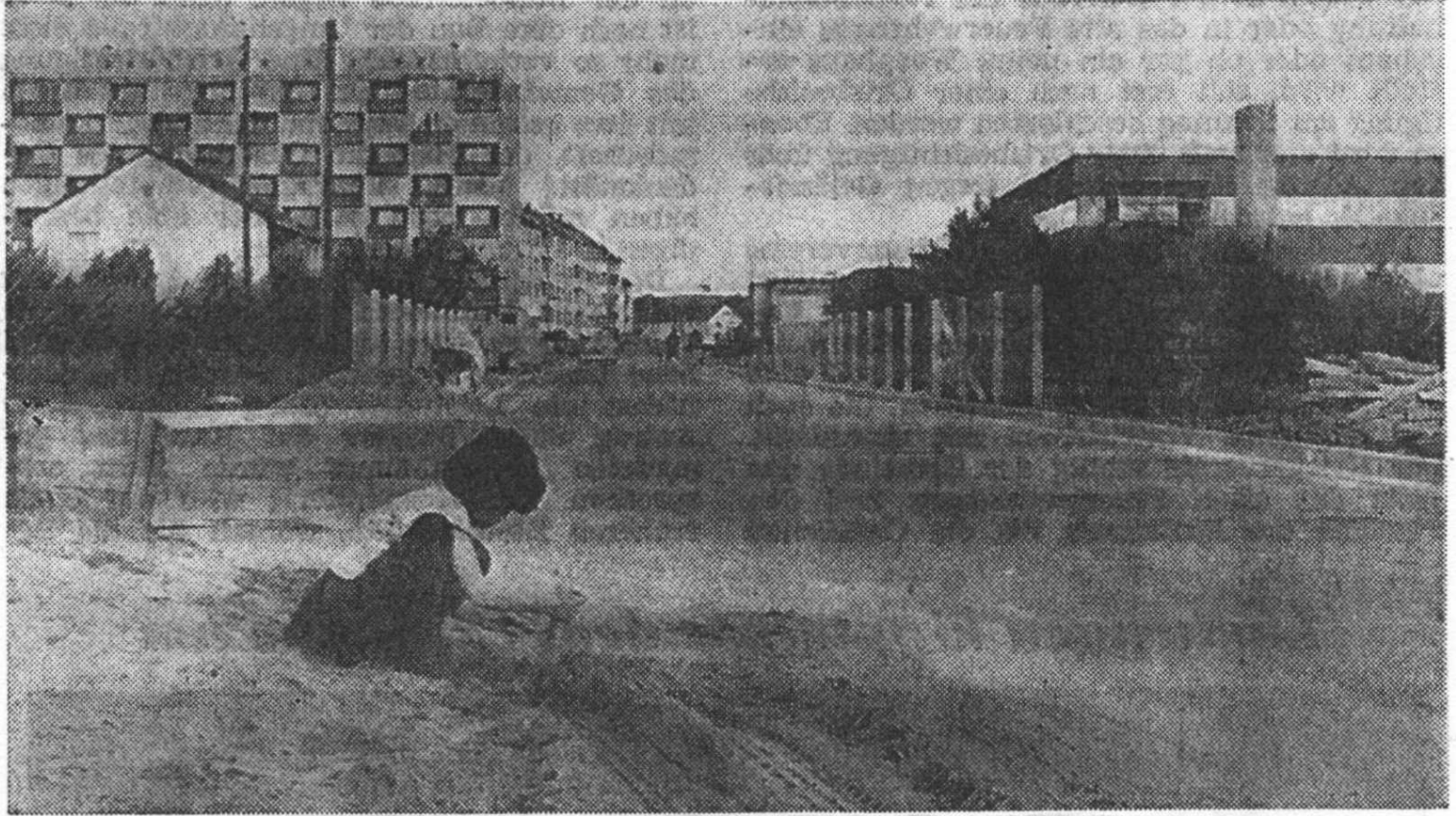
Blick von der Breitstraße in die neu ausgebaute Mariusstraße. Mit dieser Straße ist eine vorzügliche Verbindung zwischen dem westlichen und dem östlichen Teil des Rügländer Viertels geschaffen worden. Foto: Tost
